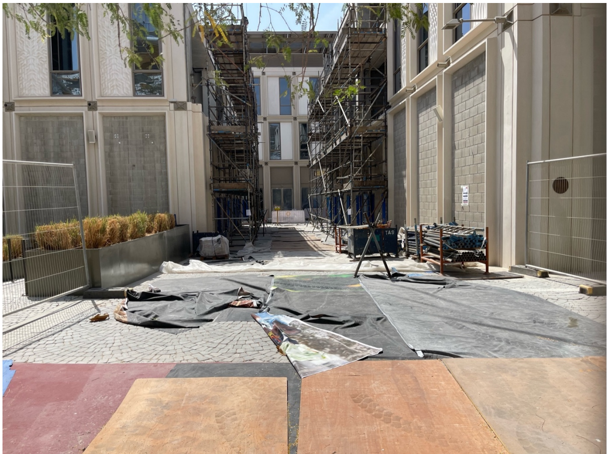
24. Arrachage des bâches publicitaires recouvrant les façades des anciens Pavillons de Dubaï Expo 2020. Les murs de parpaings aveugles ont ici fonction de panneau d'affichage (Benchetrit, 2023)
