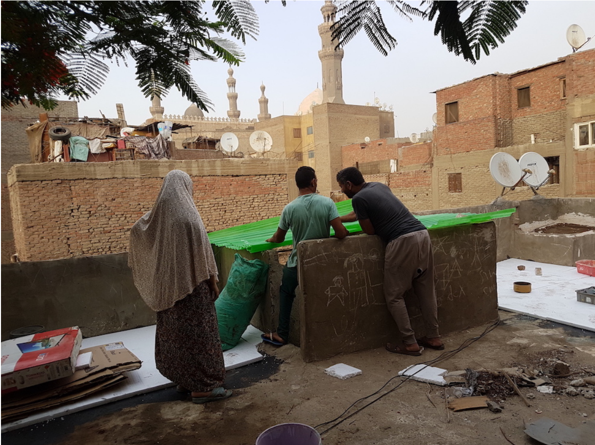
9. Installation de la protection solaire en sortie d'escalier (Ghodbane, mai 2018)
